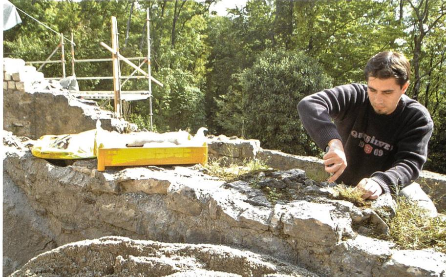
Am Westzwinger wird der zerstörte äussere Mauermantel mit frostbeständigen Steinen neu aufgebaut.
