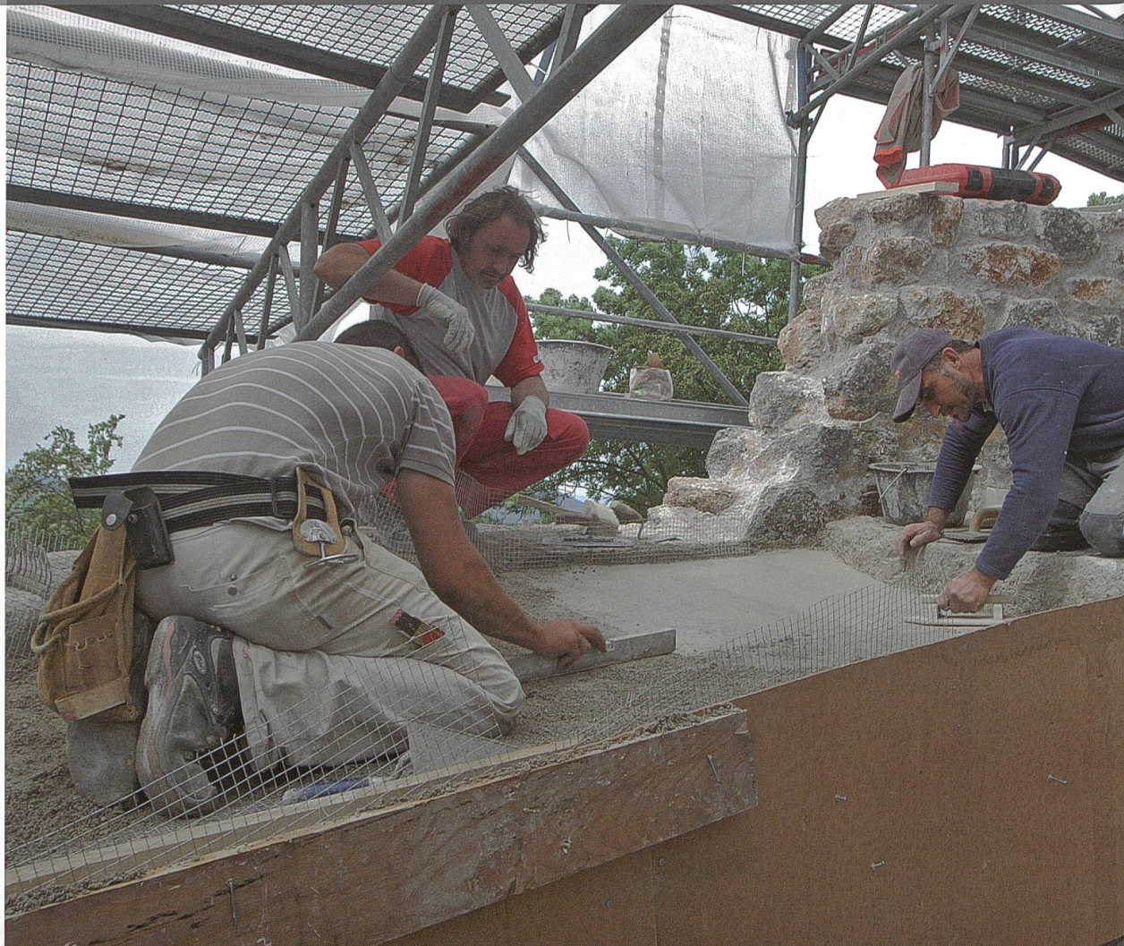
Läufelfingen, Homburg. Mitarbeiter der Firmen Sekinger und Erne beim Aufbringen des wasserdichten Überzugs auf der Mauerkrone des Wohnturms.
