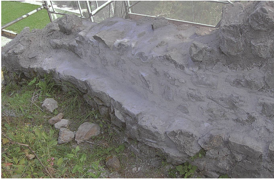
Gesicherte Mauerkrone der südöstlichen Beringmauer.
