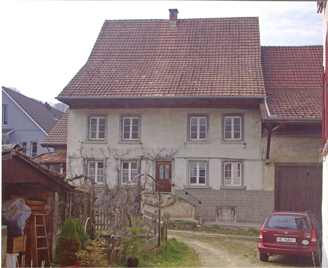
Buus, Zuzgerstrasse 5. Das um eine Häuserzeile zurückversetzte Wohnhaus.
