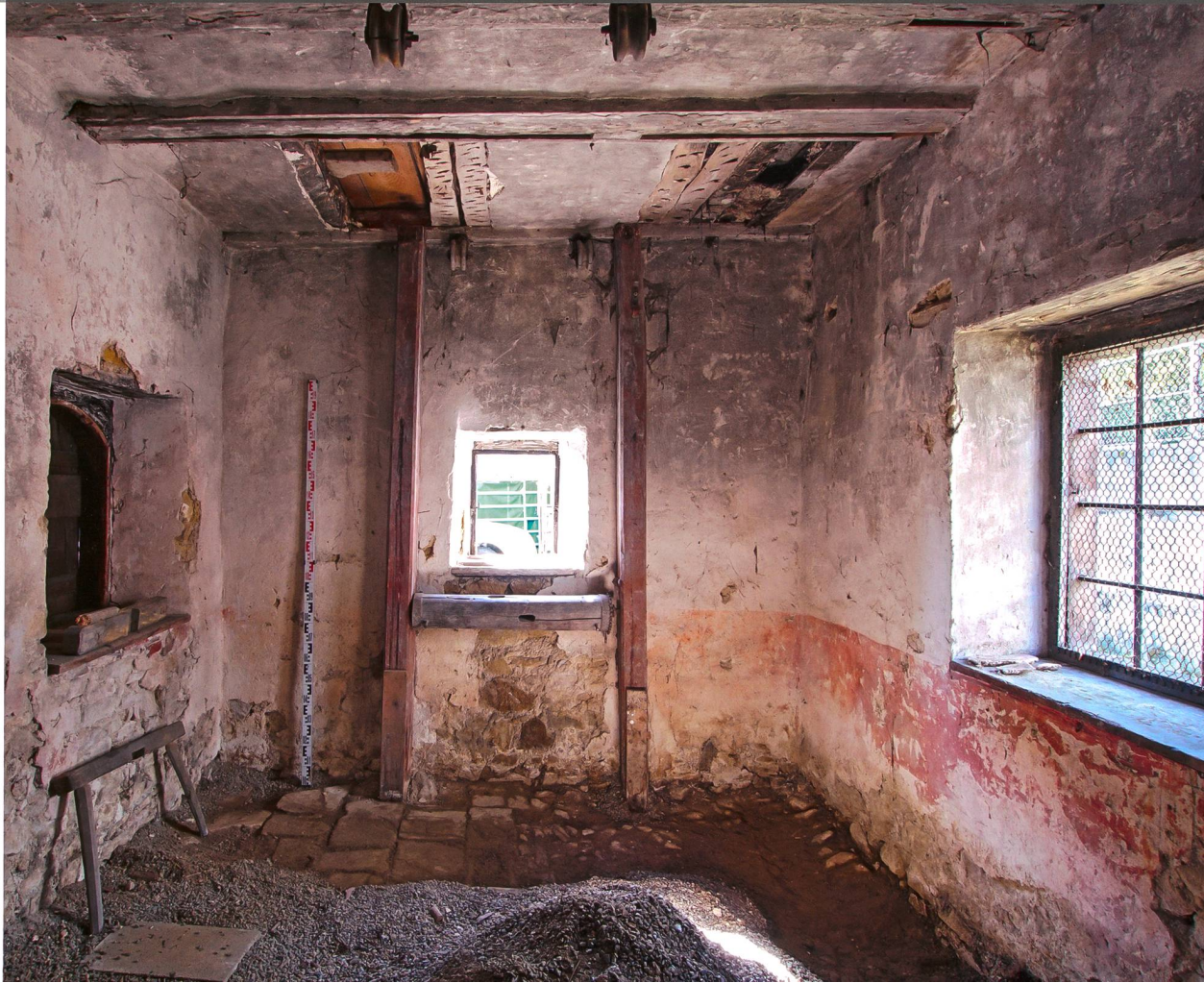
Ziefen, «Alte School», Hauptstrasse 105. Blick an die Ostwand mit Aufzugsvorrichtung und blutrot gestrichener Sockelzone.
