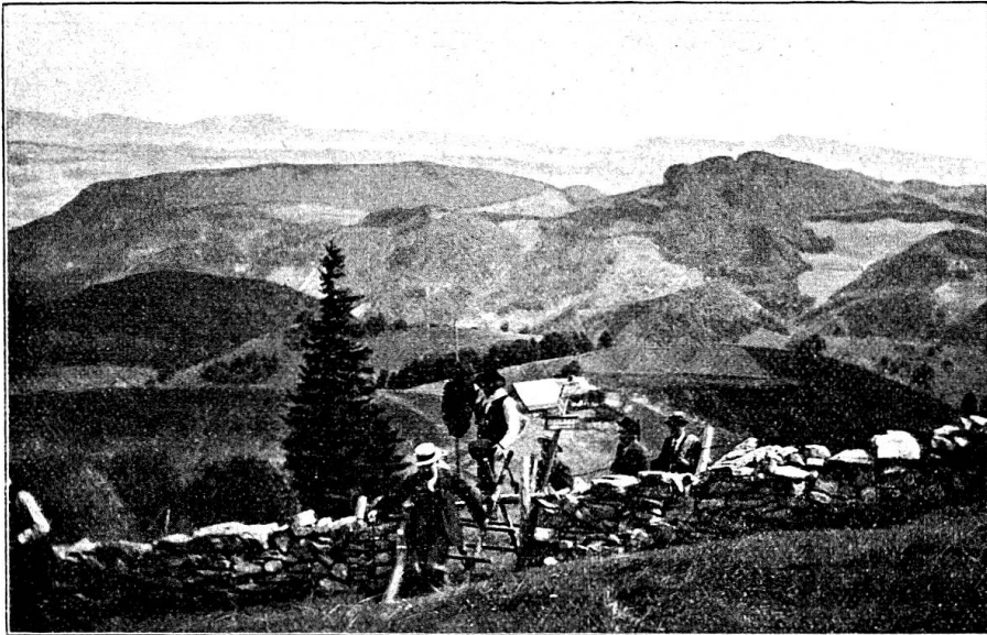
Eine Trägerrotte auf dem Weg zur Feuerlinie.
