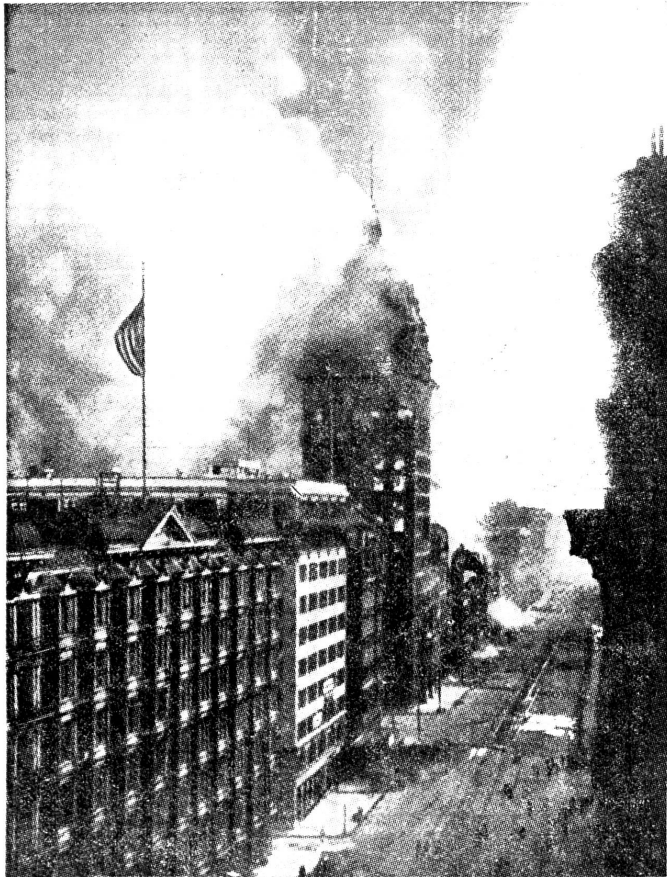
Grossfeuer nach dem Erdbeben in San Francisco. Die Bauten haben das Beben überstanden, sind aber nachher durch Grossfeuer zerstört worden.
