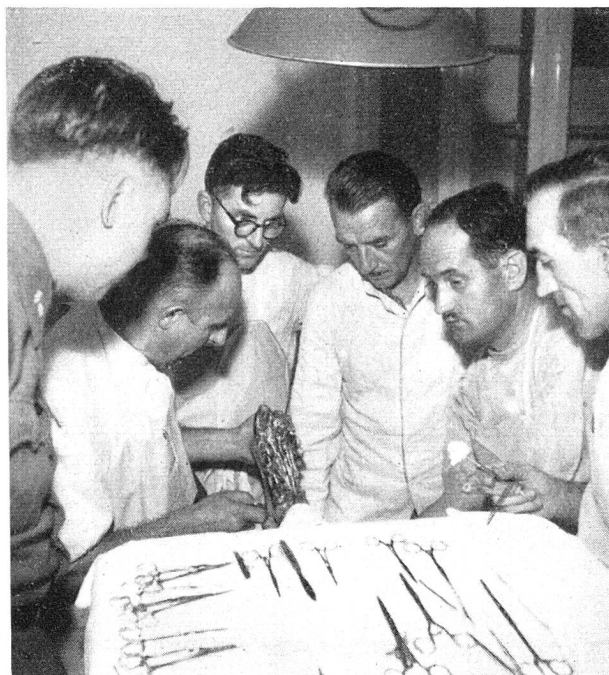
Im Operationszimmer des Luftschutzbunkers Oerlikon.
