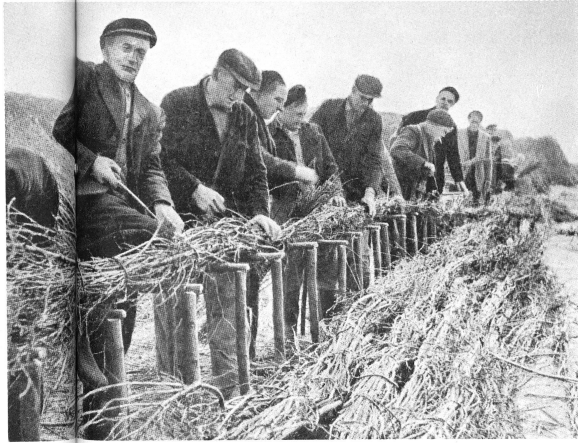
Bild rechts zeigt einige der für den Deichbau sehr wichtigen Reisgarbeiter beim Bündeln von Weidenreisig.
