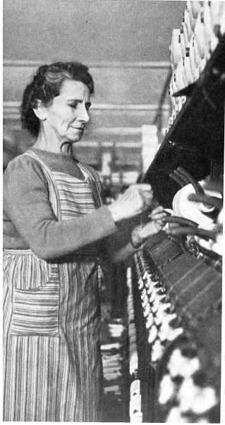
Zuvorkommend weilt uns Fräulein Lina Moser in die Geheimnisse der Spulmaschine in der Leineweberei Schub ein, so sie, vom Lärm unzähliger Maschinen umbraust, vor ihrer Maschine steht, eine Menge Spulen überreicht, zerrissene Fäden knüpft und Spulen austauscht. «Das Blutspenden tut mir guts», wehrt sie unseren Dank ab.
