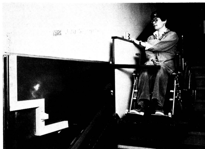
Der Eingang zum Zentrum an der neuen Adresse weist zwar einige Stufen auf, doch können diese von Rollstuhlbenützern dank einem Lift leicht überwunden werden.
