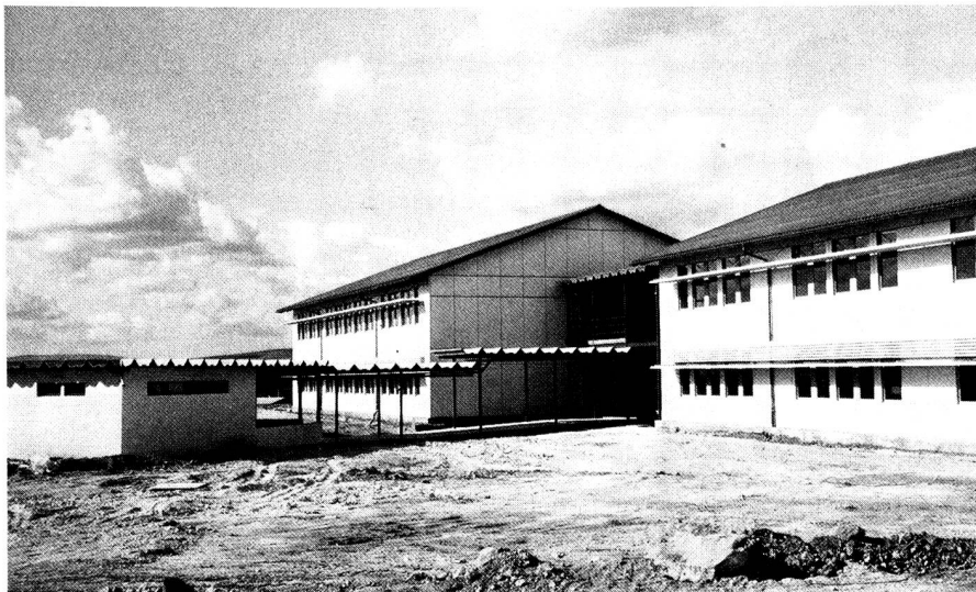
Das mit Schweizer Hilfe erbaute Lyzeum für 1000 Mittelschüler von El Asnam ist weitgehend erdbebensicher ausgeführt; es enthält 25 Unterrichtsräume. Dazu gehören ein Verwaltungs- und Diensttrakt und zwei Wohnhäuser.
