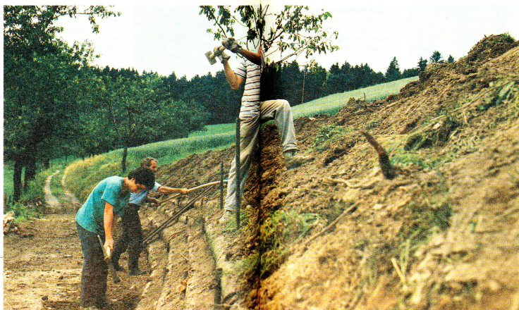
Freiwillige beim Wegbau bei Widmatt.
