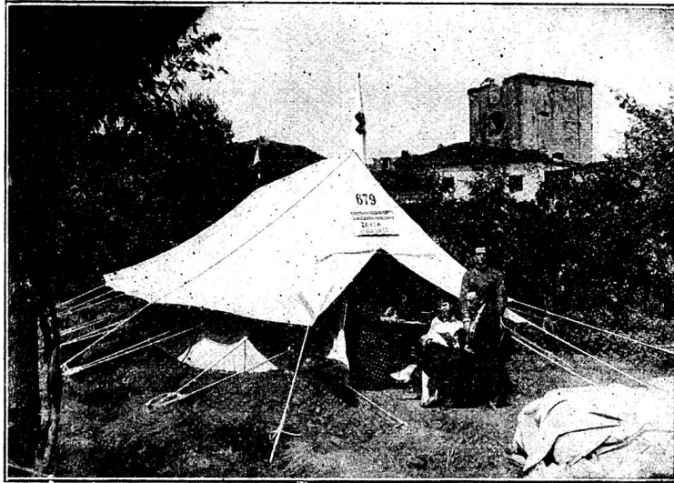
Poste télégraphique et téléphonique à Vicchio (installé quelques heures après le désastre).
