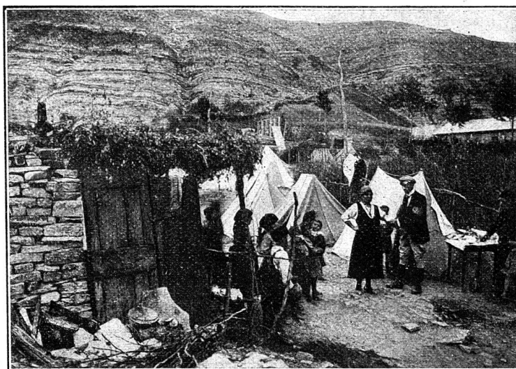
Poste de secours à Casaglia (dans le fond, baraquements en construction).
