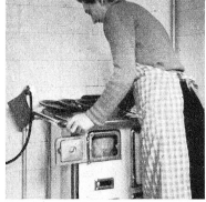
Maintenez fourneaux, cuisinières, appareils de chauffage et canaux de fumée propres et en parfait état. Faites remplacer sans retard toute prise, tout cordon électrique, tout tuyau d'amènée de gaz défectueux ou usés.
