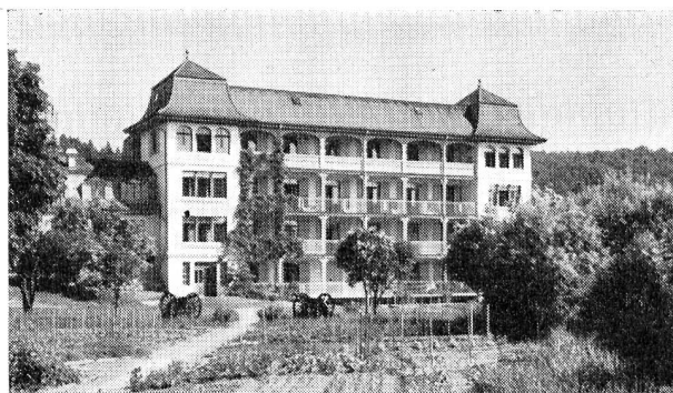
La caserne du Chanet, ancienne maison de santé.
