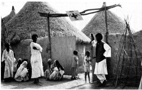
① La polyclinique de la CRS à Wad Sheriffie. Elle est construite sur le même modèle que les maisons du village: murs en torchis, toits de paille.
