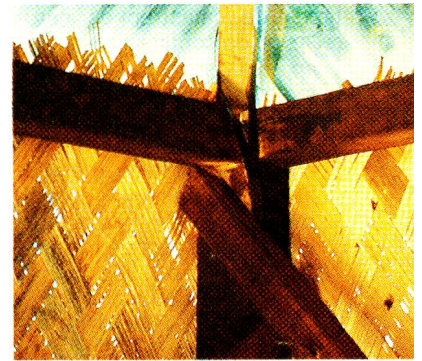
Détail de l'intérieur. Les matériaux locaux, ici les feuilles de bambou, sont systématiquement utilisées dans la construction.
