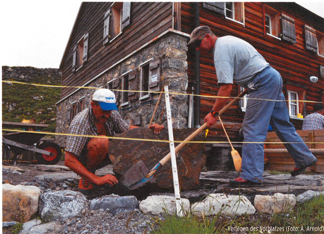
Verlegen des Vorplatzes (Foto: A. Arnold)
