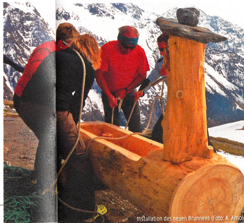
Installation des neuen Brunnens (Foto: A. Arnold)
