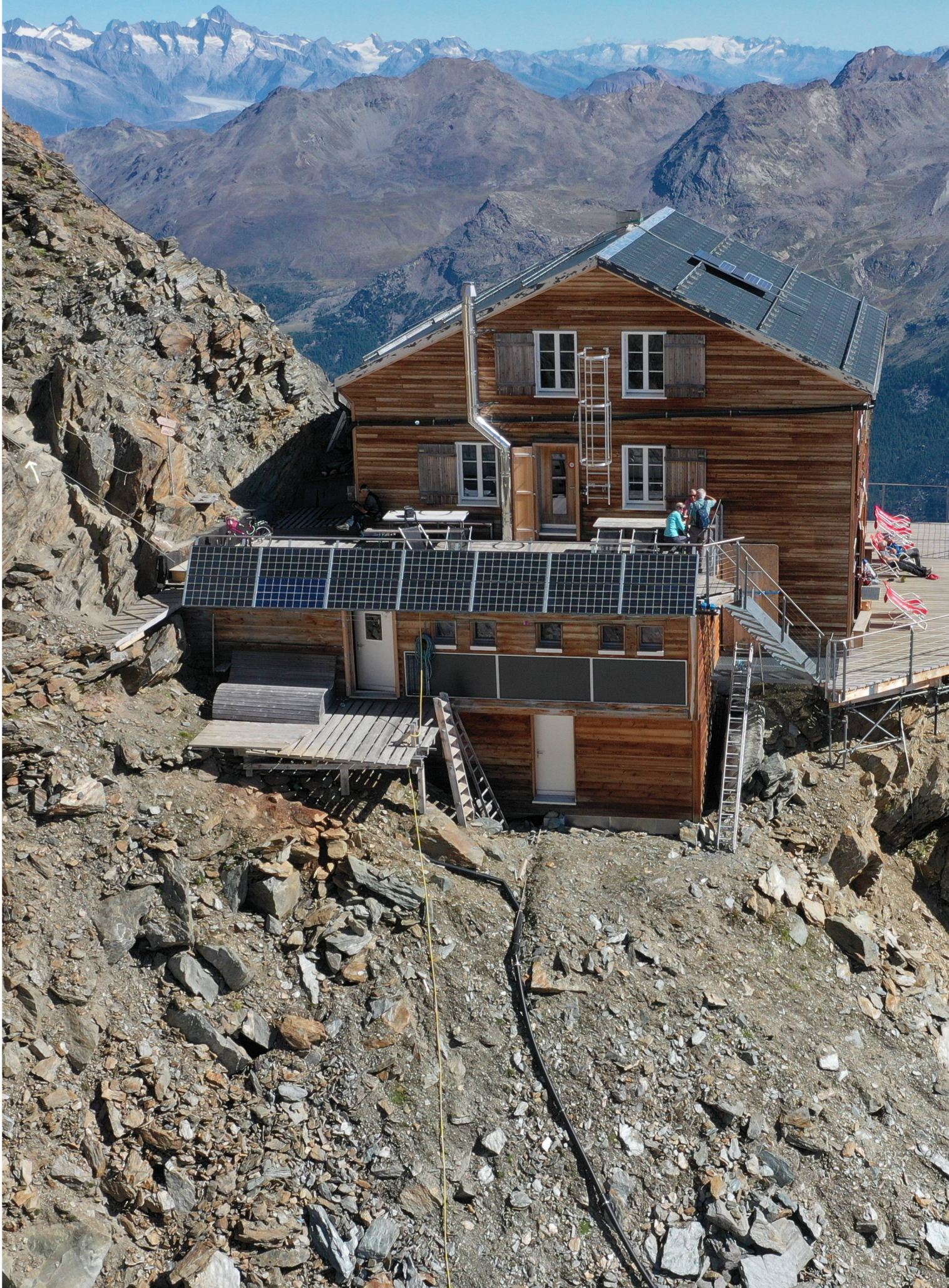
Sommer 2020 - mit der renovierten alten Mischabel-Hütte
