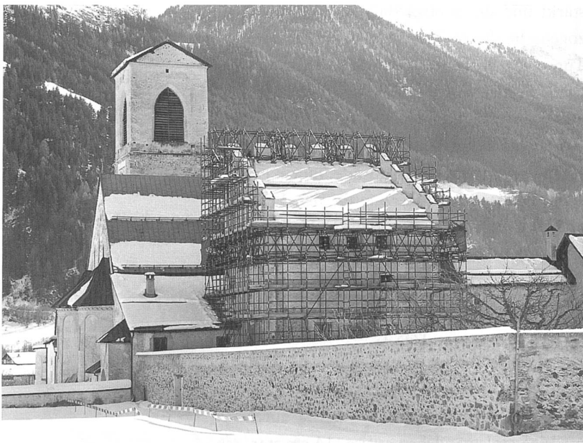
Abb. 3: Müstair 1997, Kloster St. Johann; Plantaturm mit Spezialgerüst und Sicherungsgurt im Winter 1997. Im Hintergrund die Klosterkirche.
