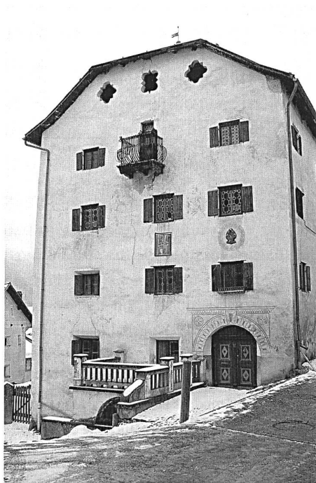
Abb. 155: Gebäudeinventar. Ardez, Haus Nr. 120. Ost- fassade.
