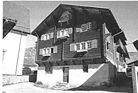
Abb. 154: Gebäudeinventar. Lumbrin, Haus Nr. 111. Südfassade.
