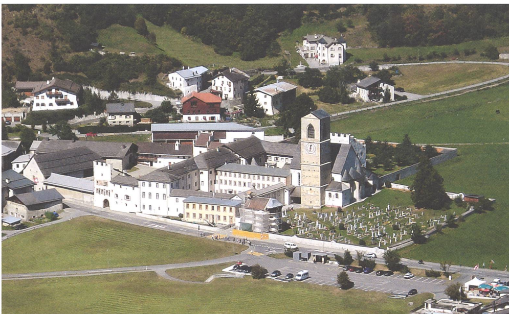
Abb. 1: Val Müstair, Kloster St. Johann in Müstair. Übersicht über die Klosteranlage mit eingerüsteter Heiligkreuzkapelle, Zustand 2009. Blick gegen Norden.
