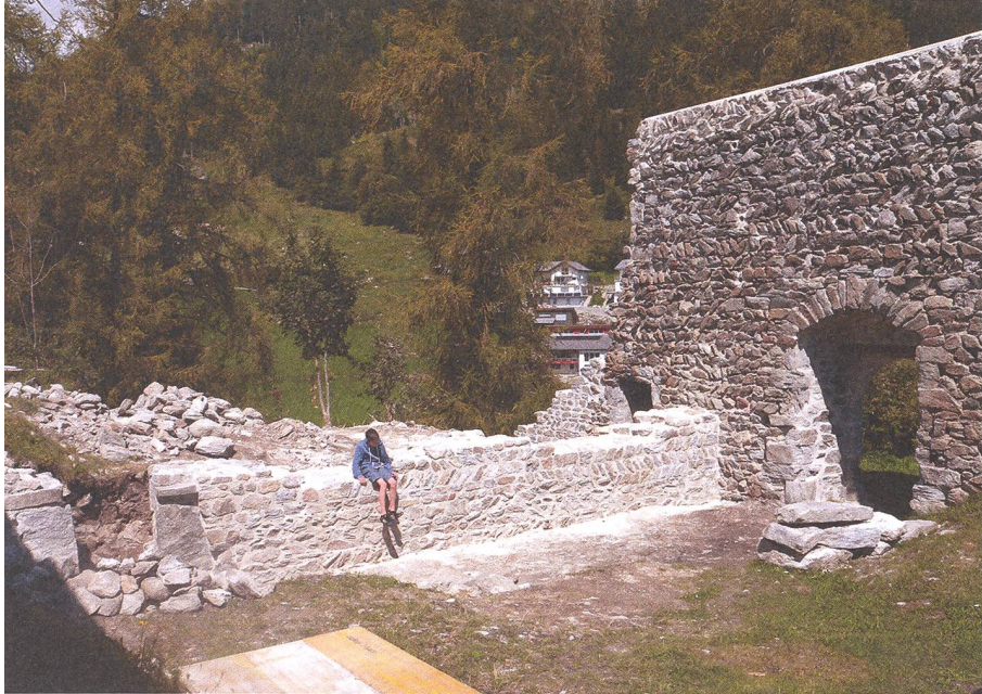
Abb. 2: Ilanz/Glion. Ruschein, Burganlage Frauenberg. 2014. Binnenmauer des Palas nach der Sicherung und dem Wiederaufbau. Blick gegen Norden.
