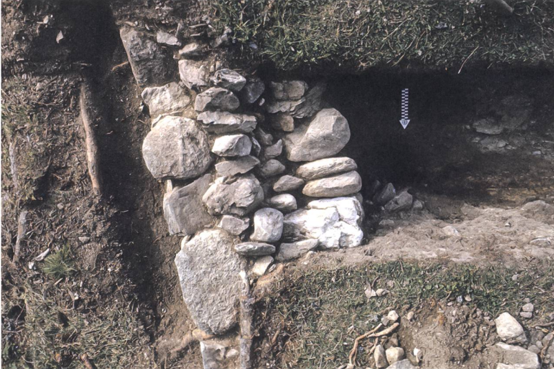
Abb. 32: Breil/Brigels, Sogn Sievi. 1970–1972. Die Umfassungsmauer des Hügels in Sondiergraben 1. Blick gegen Süden.
