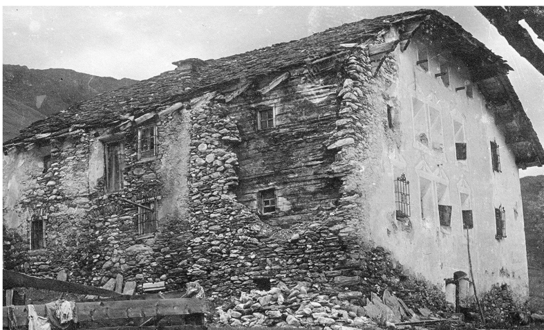
Abb. 10: Avers, Podestatenhaus. Der in Holz ausgeführte Kernbau von 1664 des Podestatenhauses ist mit Mauern ummantelt. Foto von 1910.
