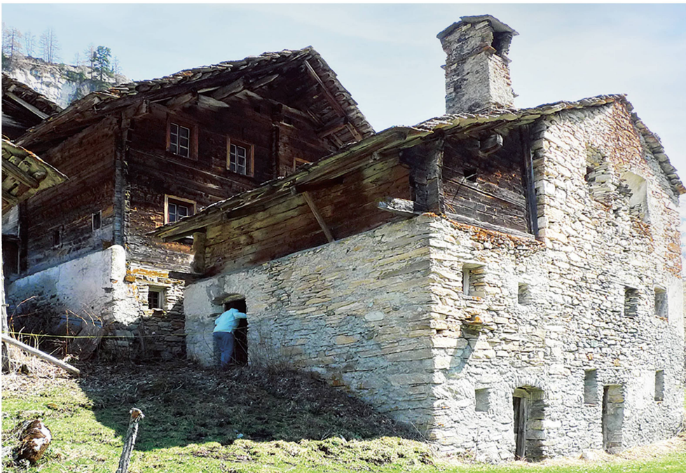
Abb. 3: Avers, Campsut. Das Höfli, ein Wohnhaus, erbaut in den 1490er-Jahren nach der im Raum Bergell/Chiavenna (I) verbreiteten Bautradition. Links der Anbau mit hölzernem Obergeschoss des 17. Jahrhunderts.
