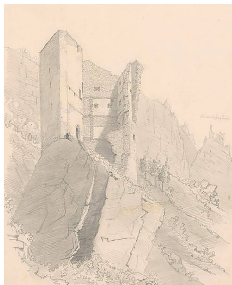
Abb. 1: Chur. Haldenstein, Burganlage Haldenstein. Zeichnung von Johann Rudolf Rahn aus dem Jahr 1862. Knapp hundert Jahre nach Aufgabe der Burg sind Dach und Zwischengeschosse des Wohntrakts bereits verschwunden. Blick gegen Nordosten.
