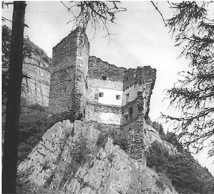
Abb. 2: Chur. Haldenstein, Burganlage Haldenstein. Ansicht von Süden vermutlich nach 1911. Rund fünfzig Jahre nach der Zeichnung von Rahn aufgenommen, zeigt diese Fotografie bereits zurückwitternde Mauerkronen, Mauern und Verputze. Blick gegen Nordosten.
