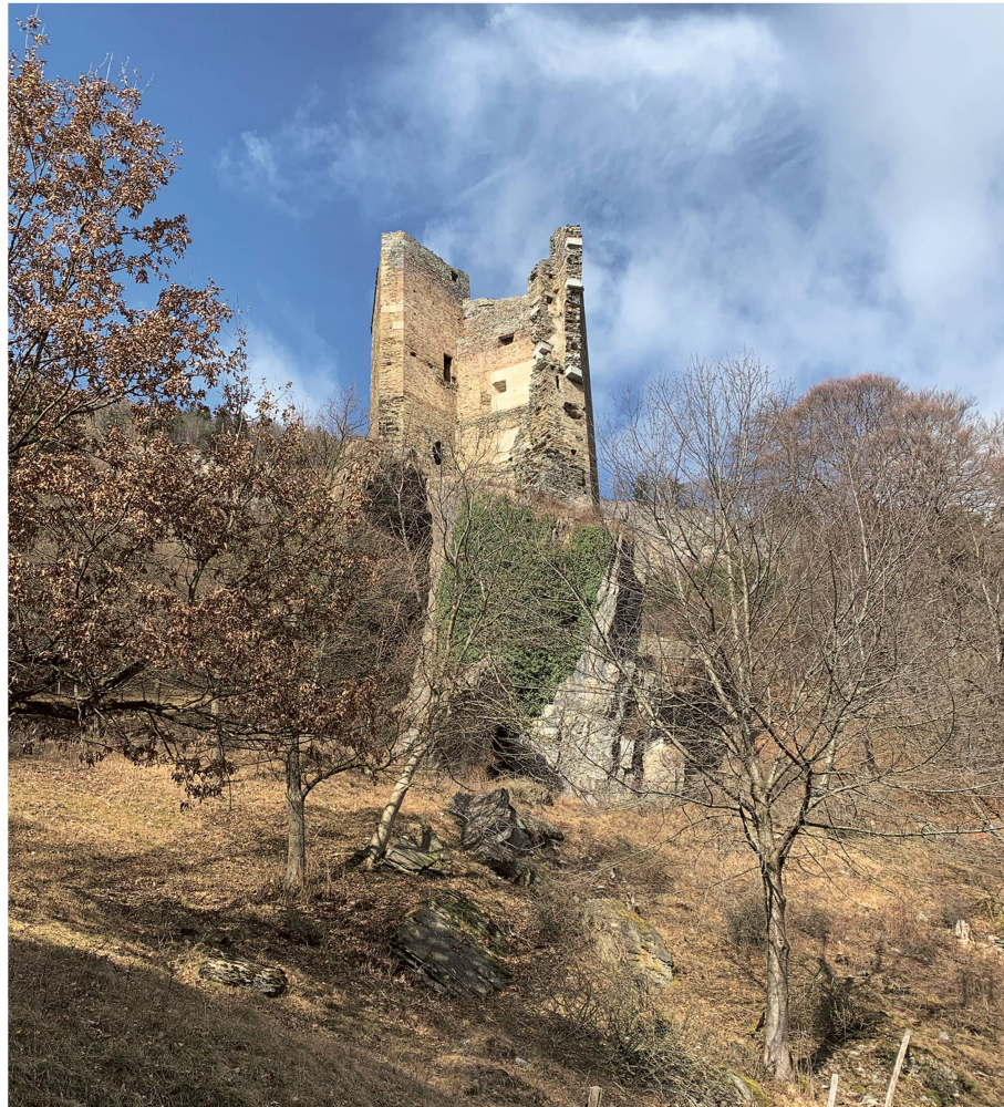
Abb. 9: Chur, Haldenstein, Burganlage Haldenstein. 2020/2021. Burgruine Haldenstein nach der Konservierung im September 2023. Auf der prominenten Südansicht sind die Betonfundamente zur Sicherung der Abbruchkanten der abgestürzten südlichen Burganlage die einzigen offensichtlichen Veränderungen durch die Konservierung 2020/2021. Blick gegen Norden.
