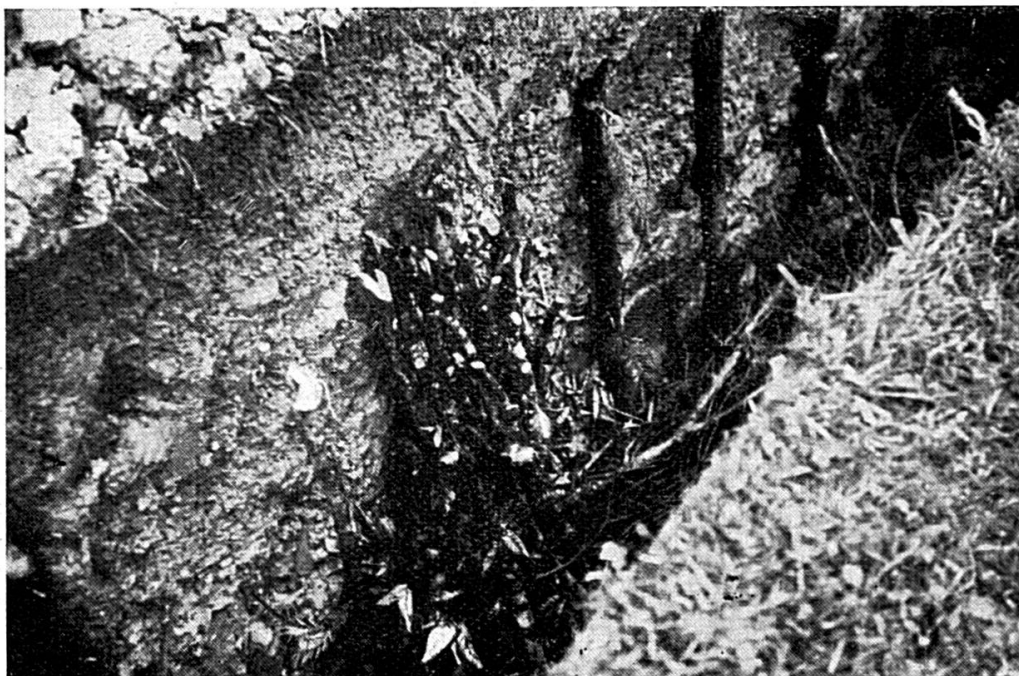
Vue d'une tranchée de drainage avec un faisceau de branchages placé verticalement. Entre les faisceaux sont disposées quelques branches. Seulement après, le fossé est remblayé.
