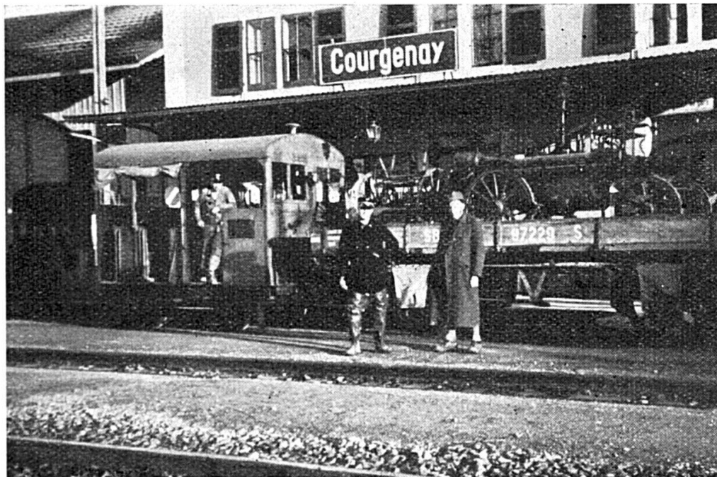
La pompe du village de Courgenay, chargée sur wagon, va se rendre au tunnel.
