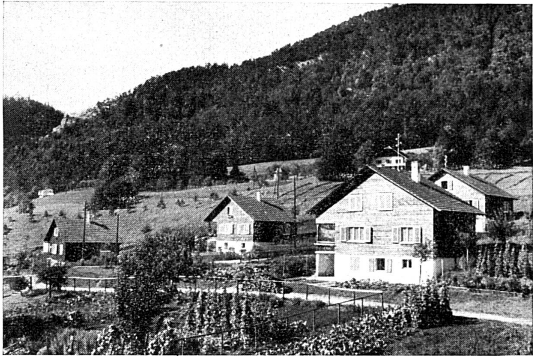
Vue partielle de la colonie « Sous-Raimeux », construite en 1943
