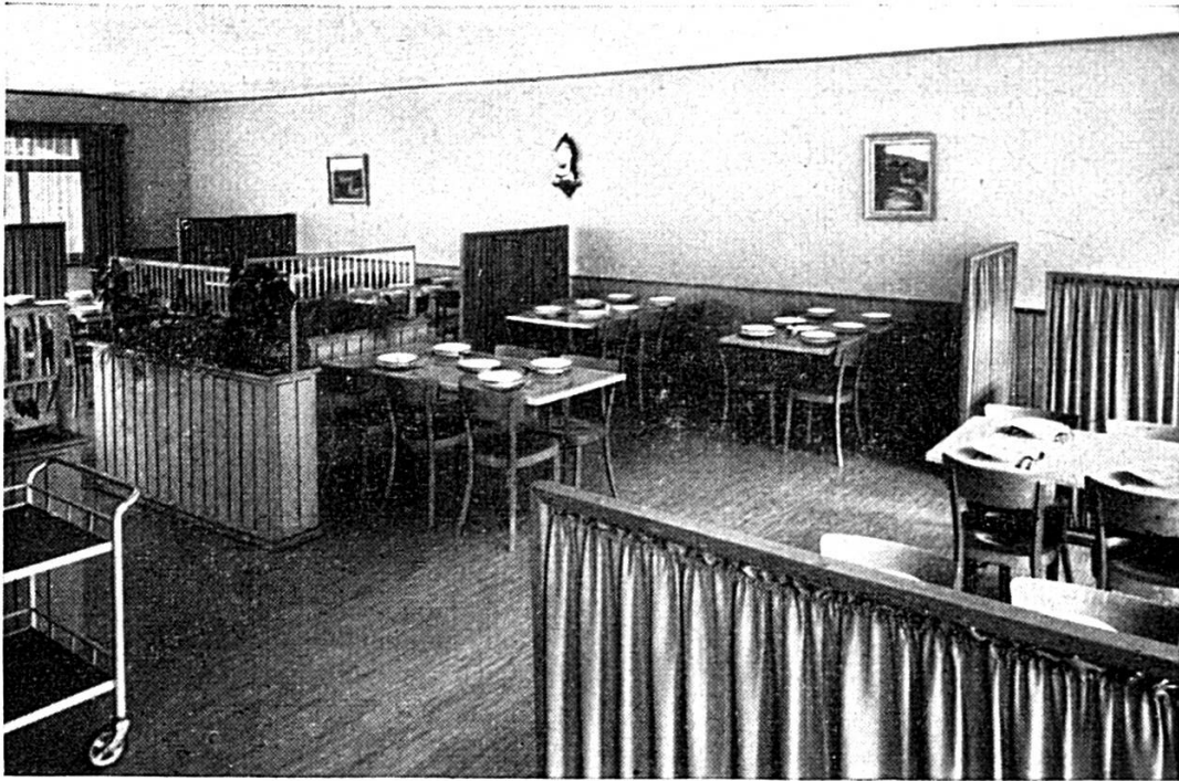
Vue intérieure du réfectoire
