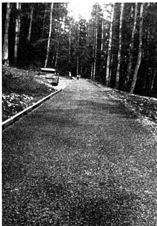
Artère forestière aménagée au système : « Compactage aux Composols »
