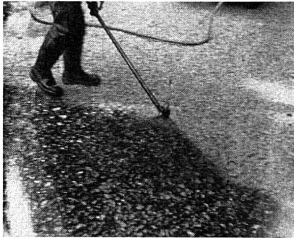
Epandage de « Composol A » à chaud
