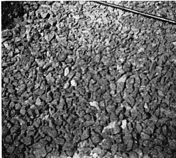
Couche de gravier dur 15/25 mm. compacté
