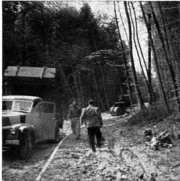
Camion déchargeant de la chaille dans le coffre
