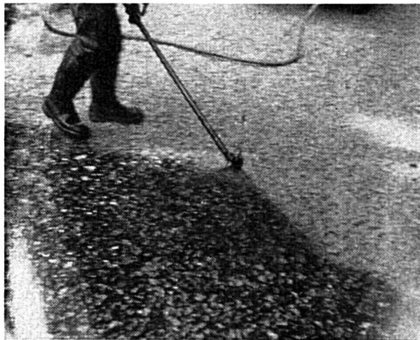
Epannage de « Composol A » à chaud
