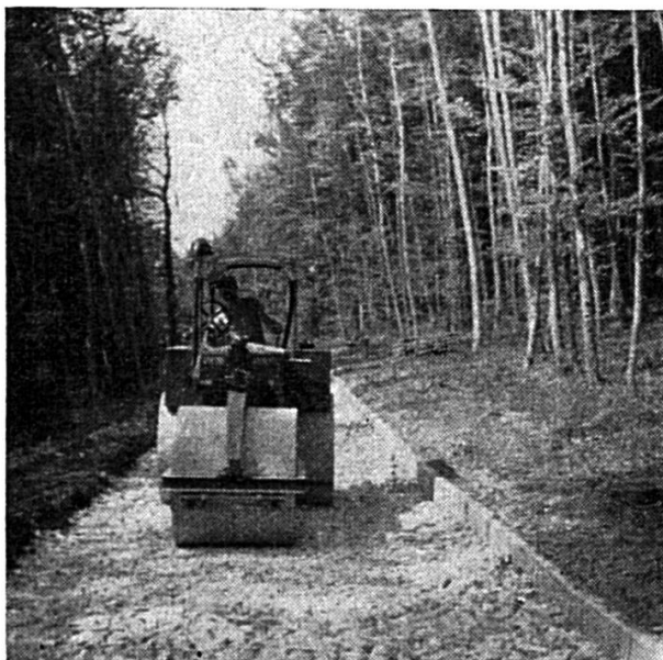
Compactage de la chaille avec cylindre
