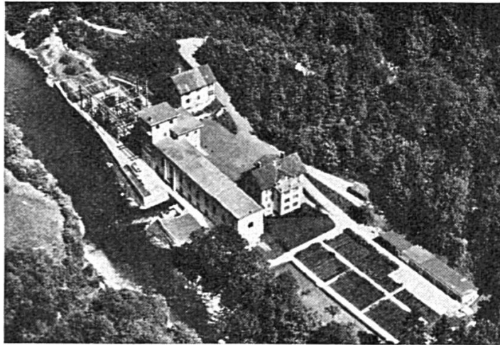
USINE DE LA GOULE SUR LE DOUBS
