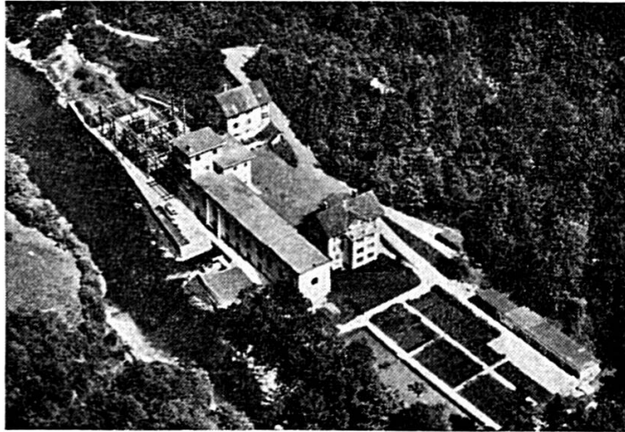
USINE DE LA GOULE SUR LE DOUBS
