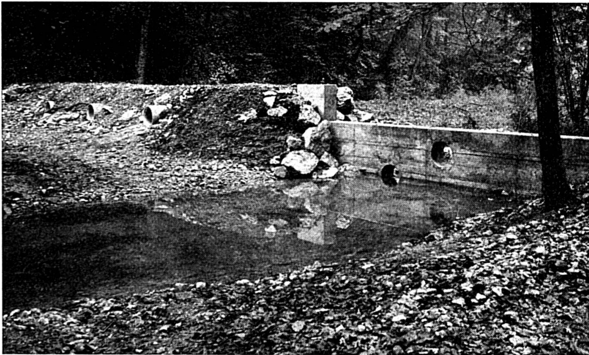
Lac de Lucelle, piège à gravier vu de l'amont.
