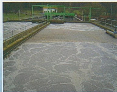
Traitement des eaux usées
