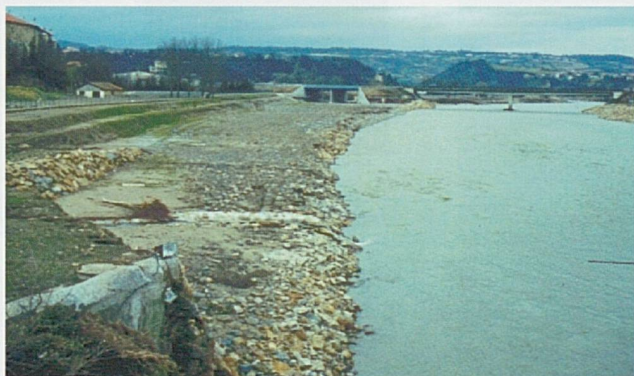
A. Vue initiale après le passage de la crue et lors des travaux préparatoires. Etat avant les travaux de revitalisation. La route à l'arrière-plan a été reconstruite avec un passage de crue.
