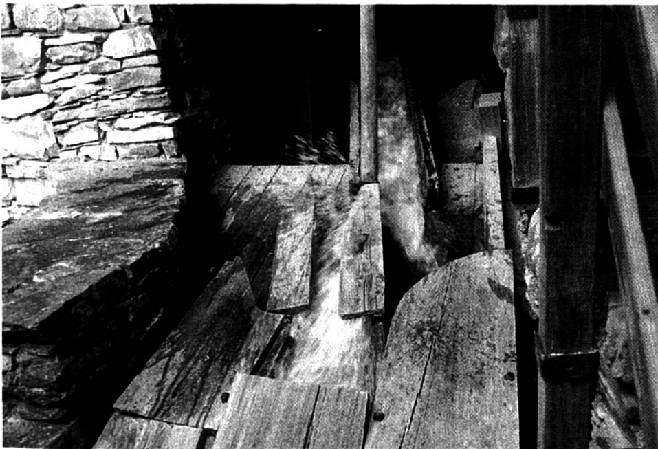
« Vieux moulins de la Tine » Troistorrents (VS). Photo Bretz, 2007.
