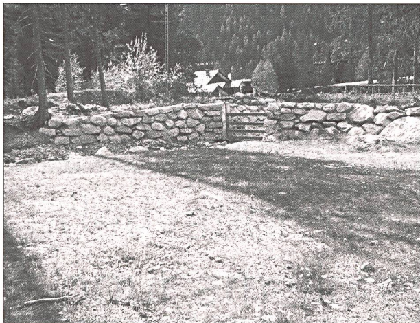
Fig. 5: Plage de dépôt du torrent des Allières (Source: SOGREAH 2003)
