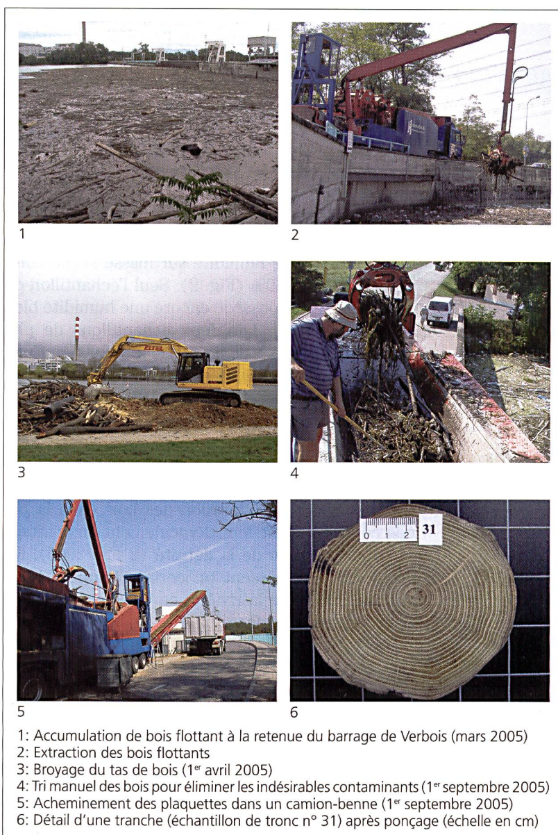
Fig. 1: Etapes de l'extraction et de la valorisation des bois flottants accumulés dans le bassin du barrage de Verbois.
