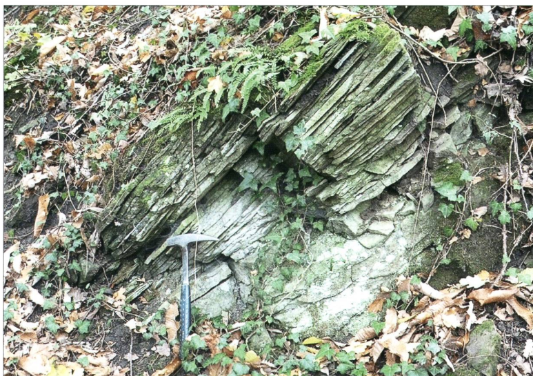
Fig. 7. Bancs de molasse conformes à la pente en aval.
