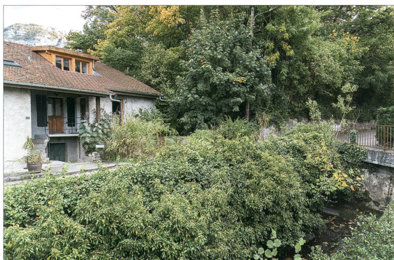
Fig. 4. L'ancien moulin du Collonges, 2017 (OPS). En amont du bâtiment, on discerne le bassin d'accumulation désaffecté. Au premier plan coule la Drize.
