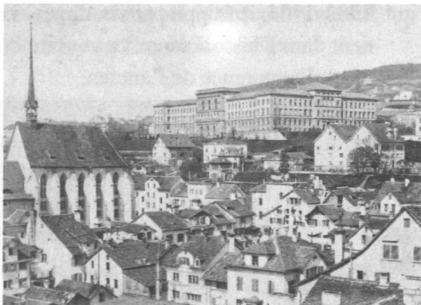
Dominant la ville de Zurich en plein essor, l' Ecole polytechnique fédérale , fondée en 1855, trône dans un bâtiment édifié expressément pour elle.
