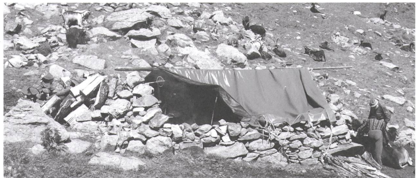
Abb. 12: Gemeinde Gerola Alta, Valle della Pietra, Alp Trona Soliva, calécc del stràch , c1017. Seitenansicht, Typus 3 , das heisst, die Firstpfette wird auf die beiden Erhebungen, matòch , gelegt. Aufnahme 2.8.2011.
