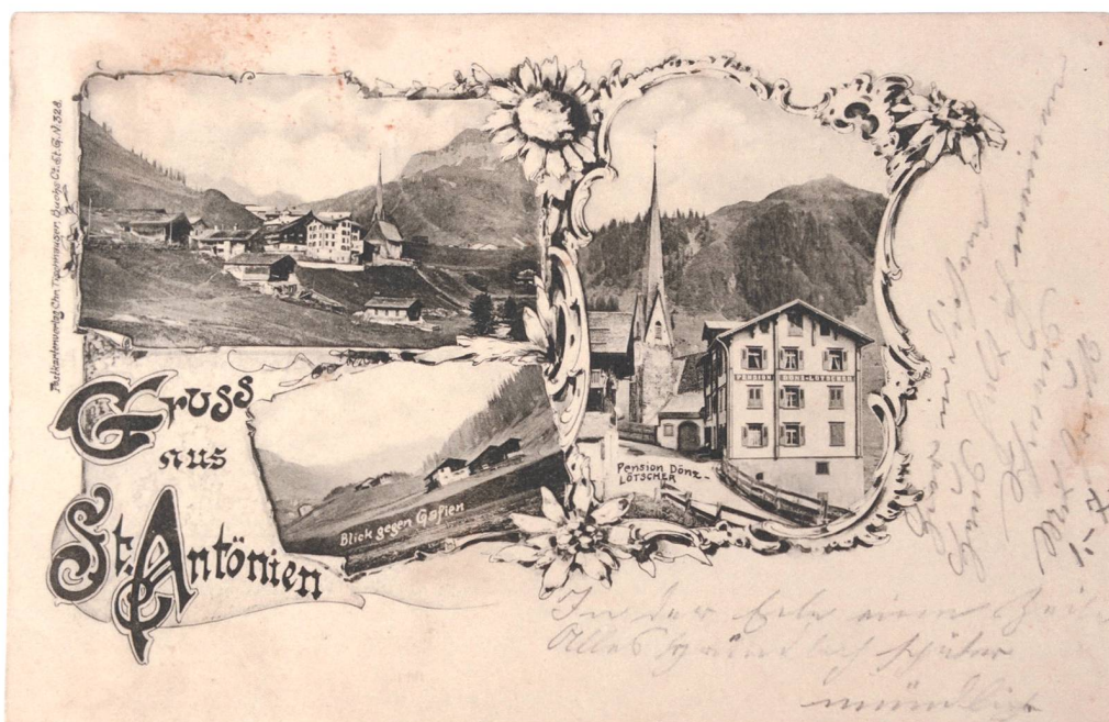
Abb. 387: St. Antönien-Platz, Pension «Dönz-Lötscher», aufgestockt und umgebaut, Ansichtskarte nach 1890.
