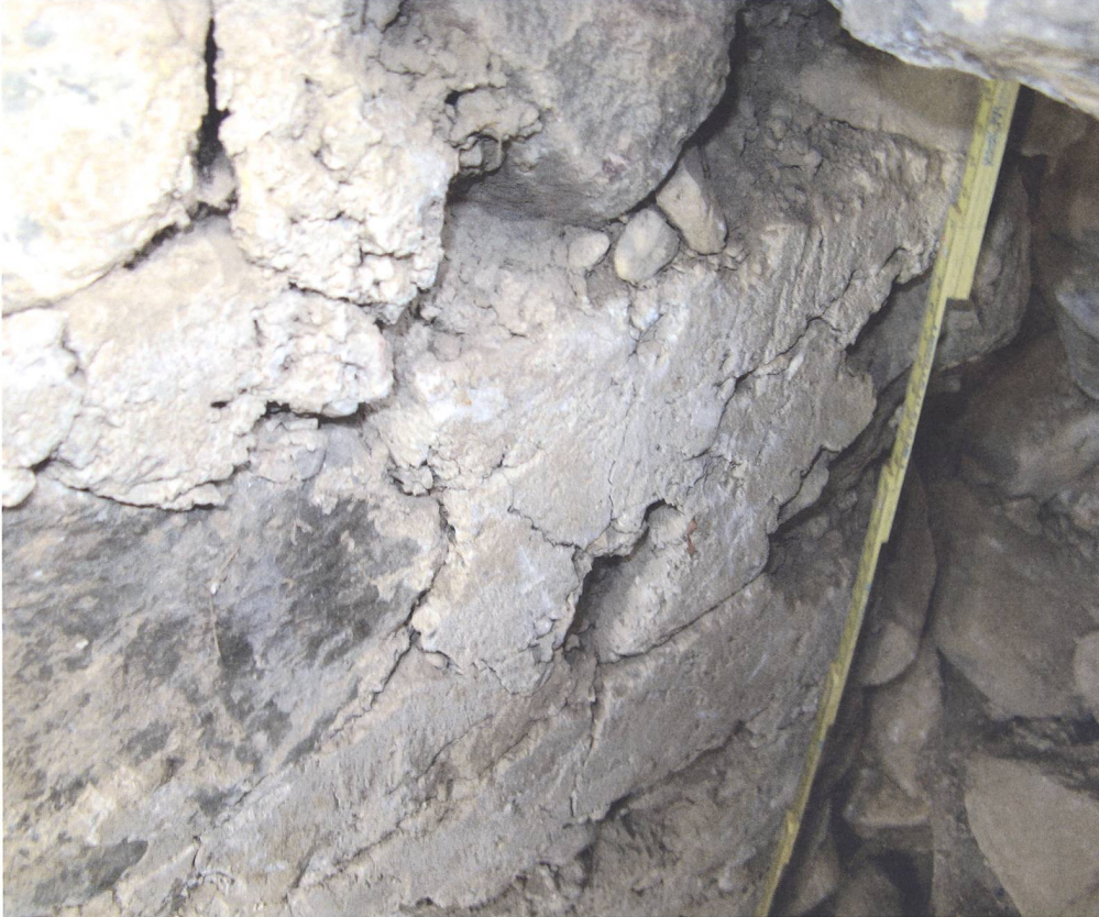
Abb. 56: Tomils, Sogn Murezi. Nördliche Leibung des Ein- ganges (1105). Blick nach Nordosten.
