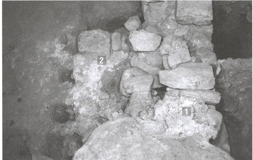
Abb. 172: Tomils, Sogn Murezi. Westannex, Raum F. 1 Reste des Einganges (1097) und 2 der vorgelagerten Stufe (1098). Blick nach Norden.
