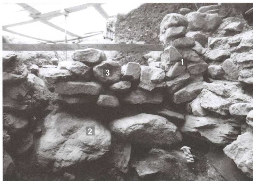
Abb. 181: Tomils, Sogn Murezi. Westannex, Raum H. 1 östliche Türleibung und 2 Schwelle von Eingang (807), 3 der Eingang wurde später zugemauert. Blick nach Norden.
