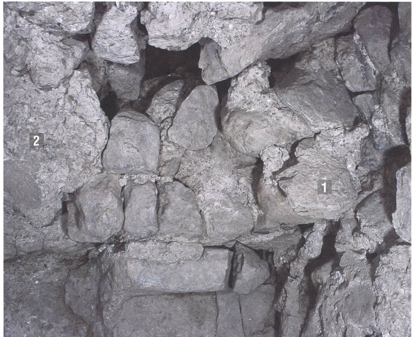
Abb. 146: Tomils, Sogn Murezi. Südannex E. Blick auf die Sitzbankreste (1046) in der Südostecke: 1 Sitzbank, 2 Flickmauerwerk (1051) der Sitzbank. Blick nach Osten.
