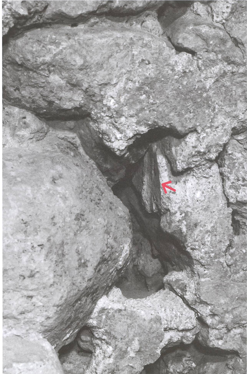
Abb. 305: Tomils, Sogn Murezi. Südannex E. Durchgang (1044). Negativ des Türstockes aus Holz (Pfeil). Blick nach Osten.
