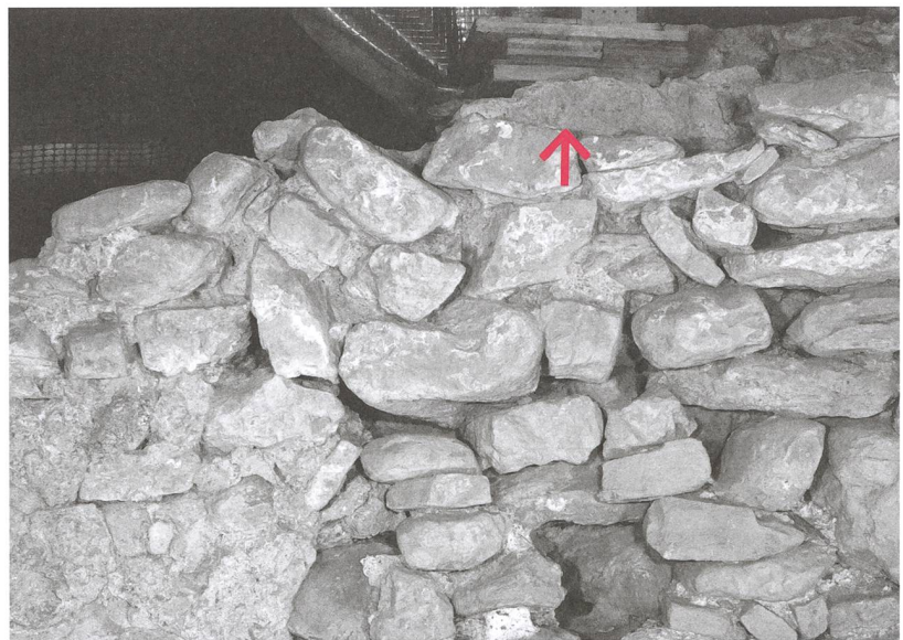
Abb. 309: Tomils, Sogn Murezi. Südannex E. Reste des Balkenlochs (1075, Pfeil). Blick nach Norden.
