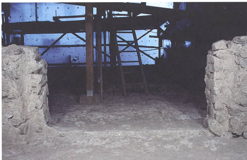
Abb. 327: Tomils, Sogn Murezi. Südannex E. Der Durchgang (1048) in der Binnenmauer (1047). Blick nach Westen.
