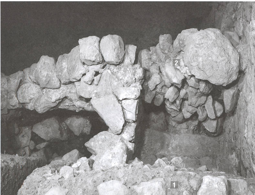
Abb. 319: Tomils, Sogn Murezi. Südannex, Osterweiterung. 1 Die Treppe wurde mit Abbruchschutt (1059) verfüllt, 2 Zumauerung (1049) des Durchganges (1044) ins obere Geschoss. Blick nach Westen.
