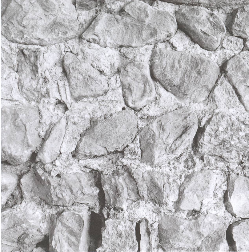
Abb. 402: Tomils, Sogn Murezi. Ausschnitt des romanischen Mauerwerks der Kirche mit Rasa-Pietra -Verputz und Fugenstrich.
