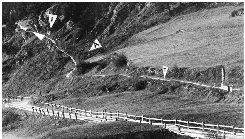
Abb. 9: Scuol. Ftan (Stelle 2.5). Alle-Zeiten-Talweg in Chandschè beim Westrand der grossen Ftaner Absackung. A Westrand der Absackung. I Inschrift (Stelle 2.6, Abb. 11 ) an der Schlüsselstelle. T Trasse des Weges mit Böschungs- und Stützmauer an der steilsten Stelle, wo der Schaden am Kulturland möglichst gering gehalten werden konnte. Blick nach Südwesten.
