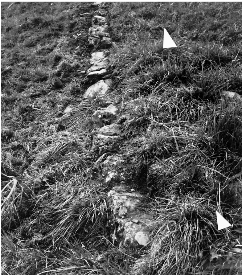
Abb. 4: Scuol. Ftan (Stelle 2.3/A). Ältester Talweg mit talseitiger Böschungsmauer. Blick nach Nordwesten.
