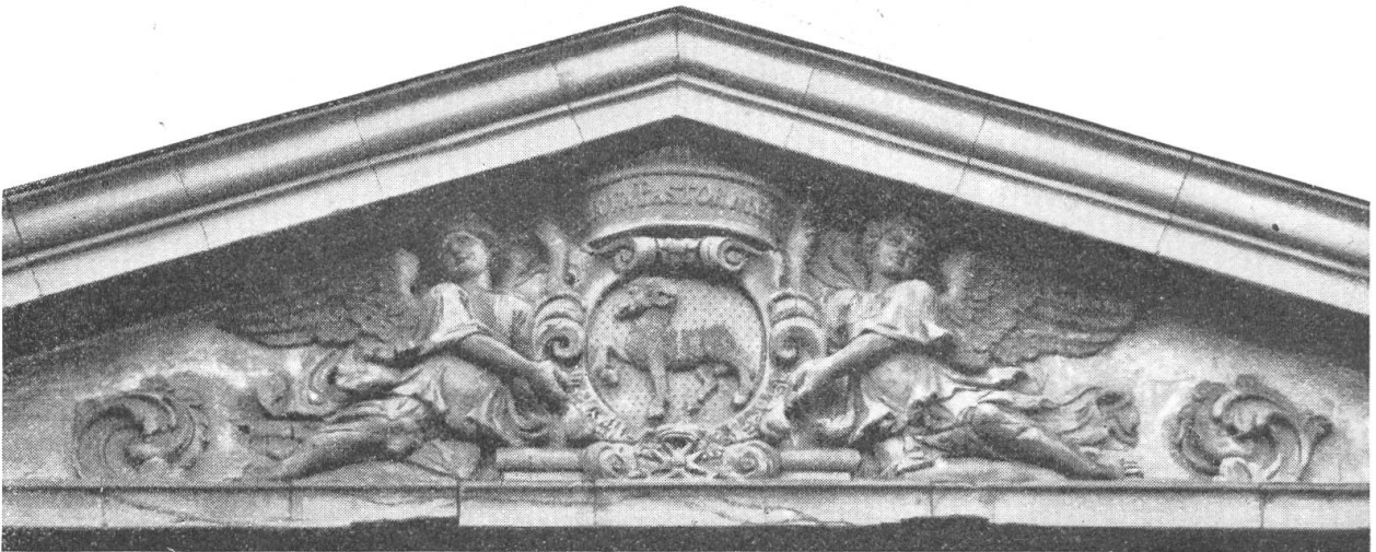
Fig. 62. Wappen des Samuel Frisching, um 1705. Junkerngasse, Bern
